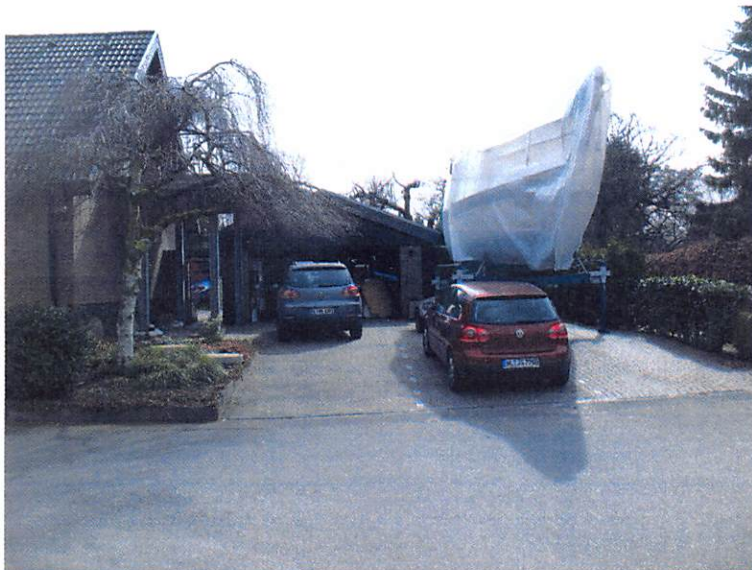
Ansicht von der "Danziger Straße" auf Garage (Gebäude 2)
