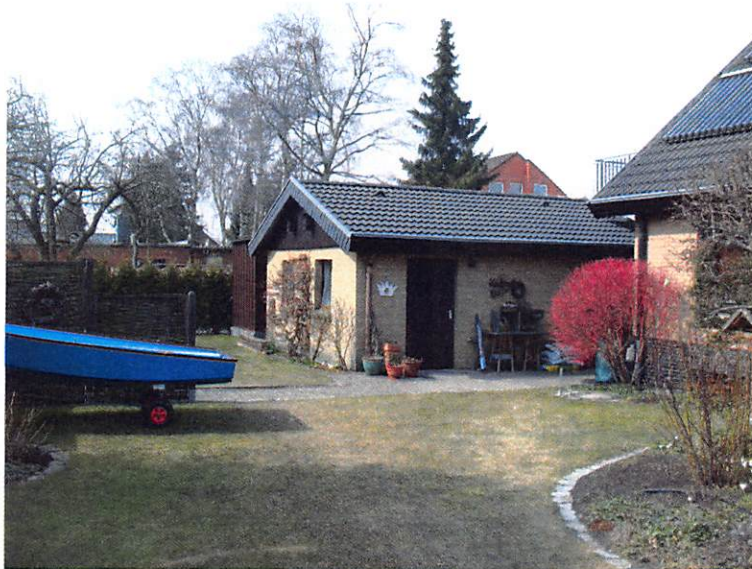
Gartenansicht auf Garage
